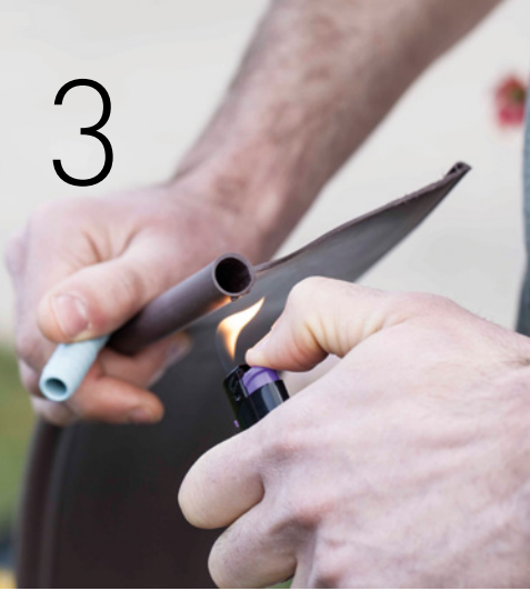
3 - Calentar los extremos para facilitar la entrada del empalme
